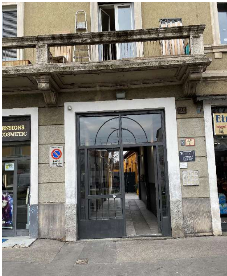
Ingresso carraio e pedonale
