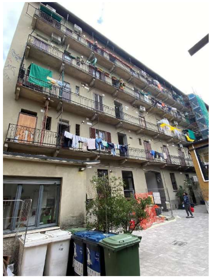
Facciata su cortile
